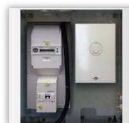
← PDL (Point De Livraison) jusqu'à 36 KVA intégré et protégé
